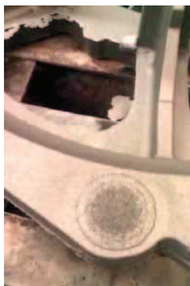
■ Fig. 8 - Resa superficiale dopo distacco NETCore ®.
